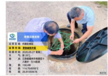
更换破损井盖
