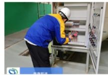
电气安全检查
