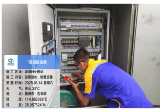
电气安全检查
