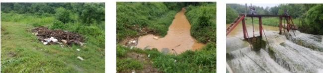
备战汛期，成立防汛应急小组，制定预案，力保汛期厂区设备与人员安全
